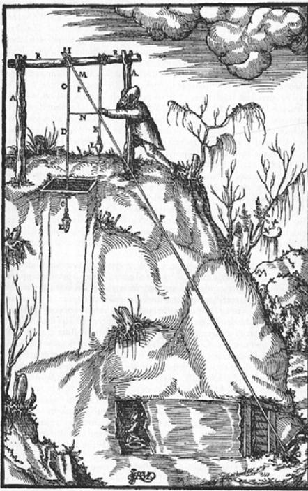
**Markscheider beim Vermessen in einem Bergwerk. Er kennt die Teufe (Tiefe) des Schachts und will die Länge des Stollens vom Mundloch (Eingang) bis zum Schacht berechnen. Dabei bedient er sich der Ähnlichkeit des kleinen und des großen Dreiecks und der Proportionen, die zwischen beiden bestehen. Holzschnitt aus Georg Agricolas „Vom Berg- und Hüttenwesen“ (1557).**
